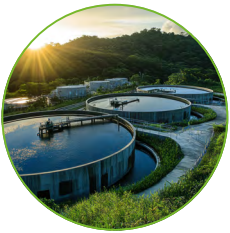
Reservatórios de água potável
